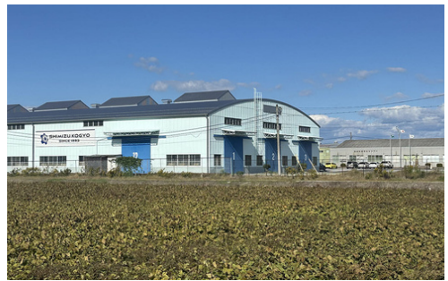
2025年に修繕が完了した第一工場
